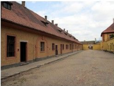
Instalaciones de la fortaleza de Terezin, en República Checa
