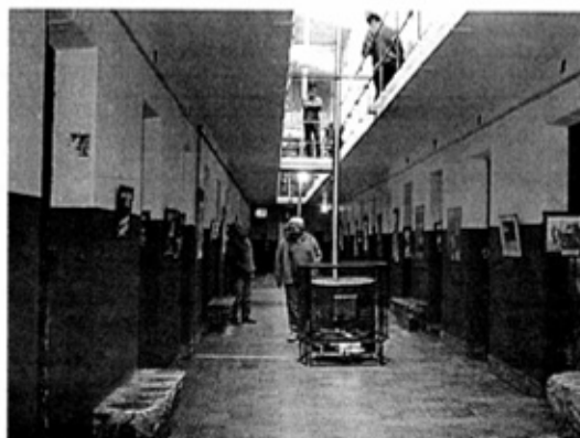
El pabellón restaurado
