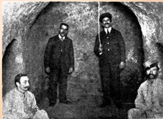
Una vista del subterráneo del Colegio Nacional Central
